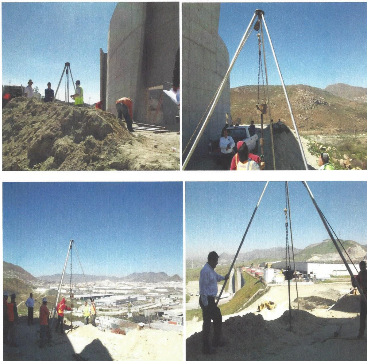
Vista panorámica de elaboración de PCA Proyecto: "C4" Centro de Control, Comando y Computo Ubicación: Carretera Libre a Tecate S/N Delegación la Presa, Tijuana Baja California
