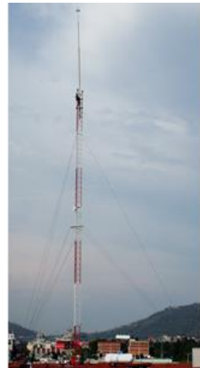
Fig. 1. Antena sujeta mediante cables, azotea de la prepa 9.
